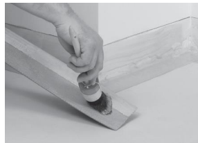
Aplicar cola no chão e contra a parede até à linha.
